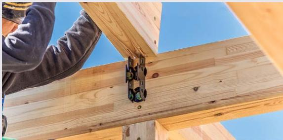
柱脚金物に柱の差し込み
