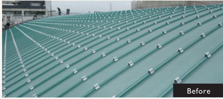
瓦棒葺き屋根
