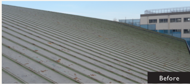
瓦棒葺き屋根
